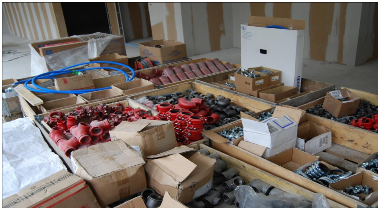
Diverse sprinkler deler klar til montering på Hauketo skole.
